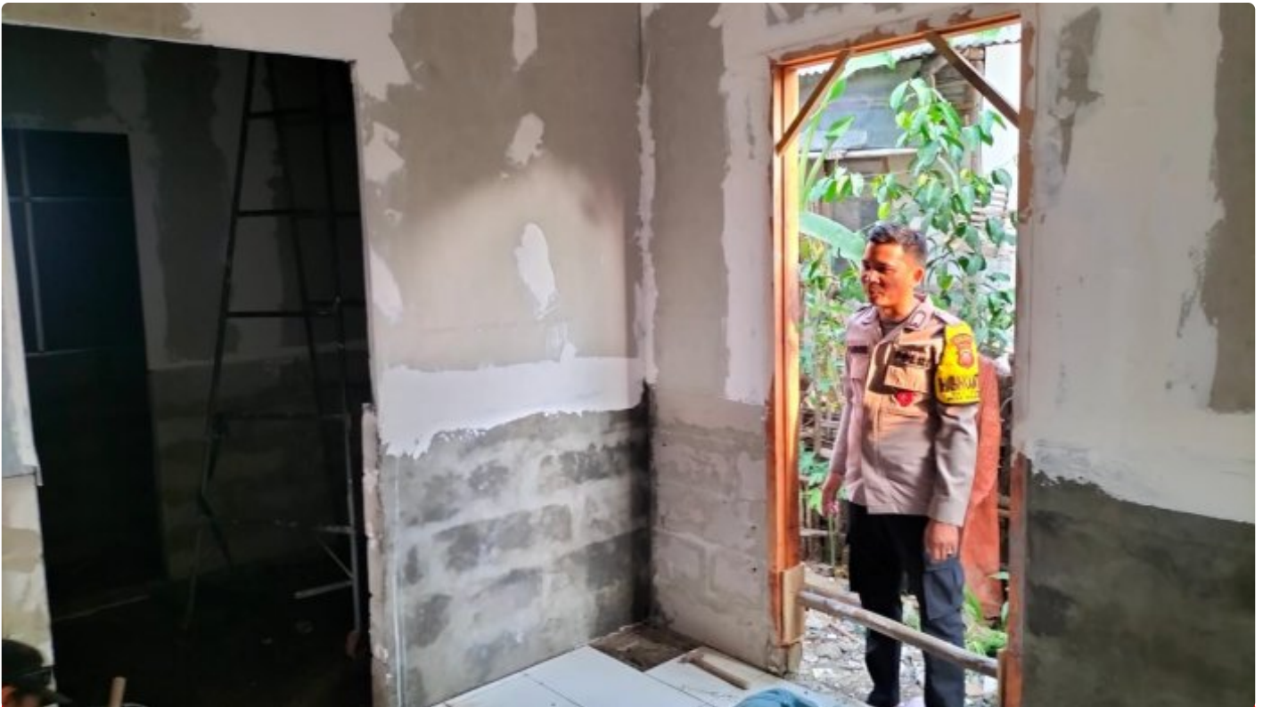
Pembangunan Rutilahu di Kecamatan Terisi Terus Berjalan Lancar
